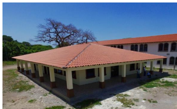
Edificio de la cafetería CURNAC
