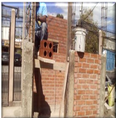
Construcción de casetas
