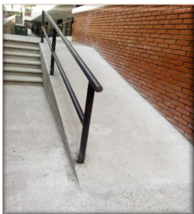
Construcción de rampa y acera
