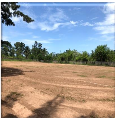
Remodelación de canchas
