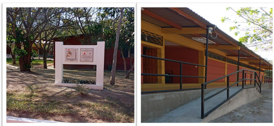
Remodelación de edificio CIIE- Gracias, Lempira
