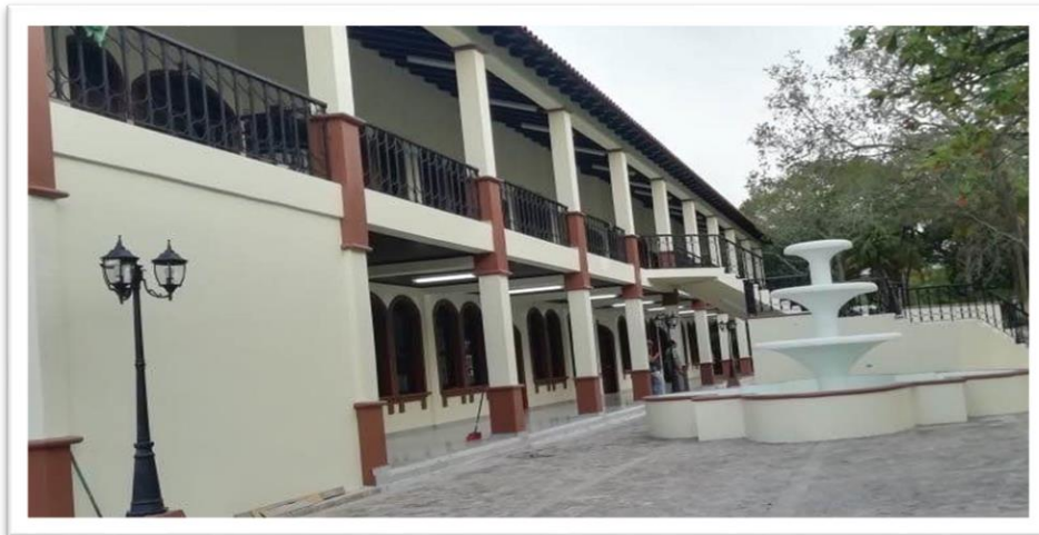
Edificio CRU-Santa Bárbara
