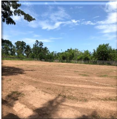
Remodelación de canchas
