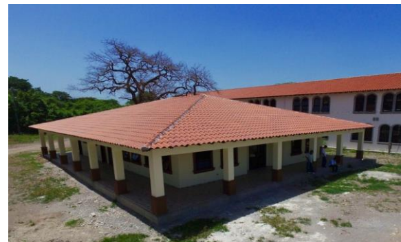
Edificio de la cafetería CURNAC
