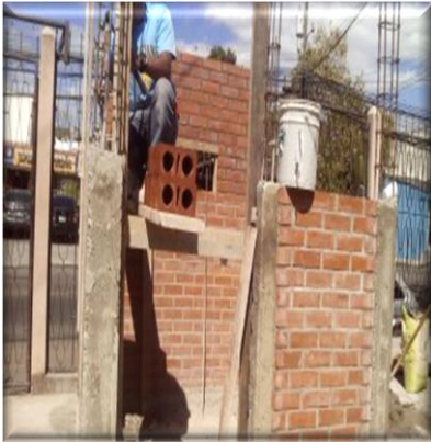
Construcción de casetas
