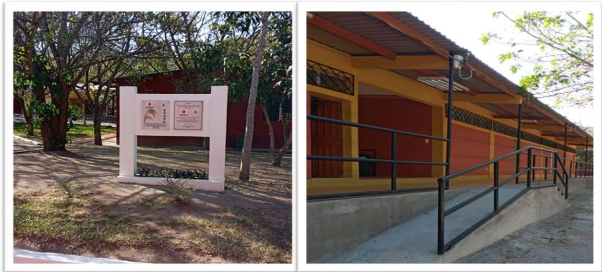
Remodelación de edificio CIIE- Gracias, Lempira
