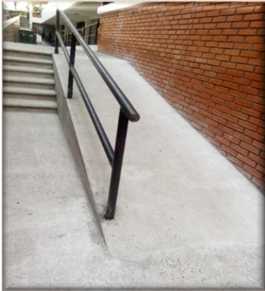
Construcción de rampa y acera
