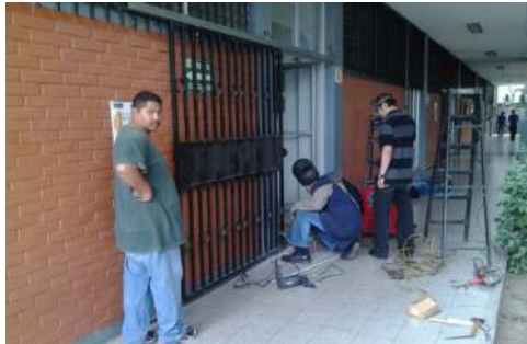
Instalación de portones ETI.
